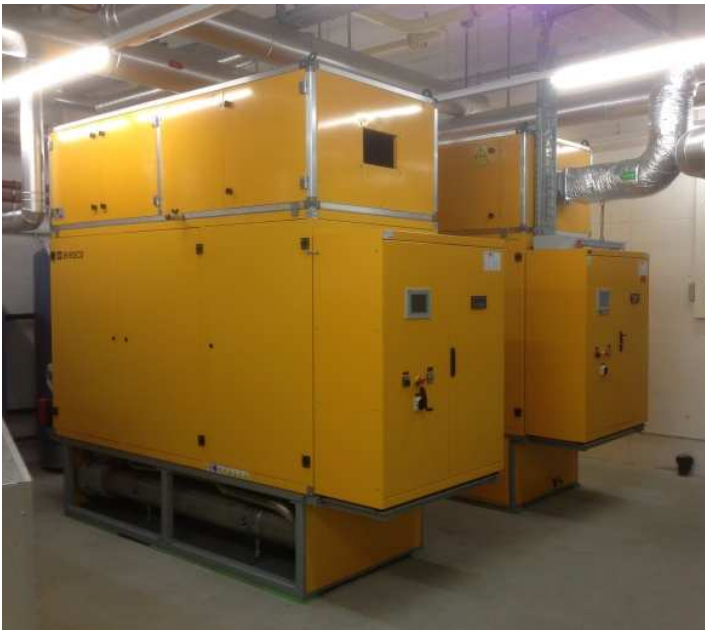
Abb. 3: Energiezentrale Nahwärmeverbund Birnbäumen mit 2 BHKW à 115 kWel.
